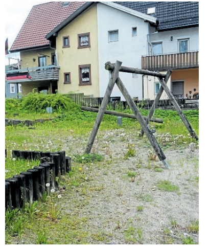
Marode Geräte: So sah der Spielplatz vor der Sanierung aus. ARCHIVFOTO: STUHRMANN
